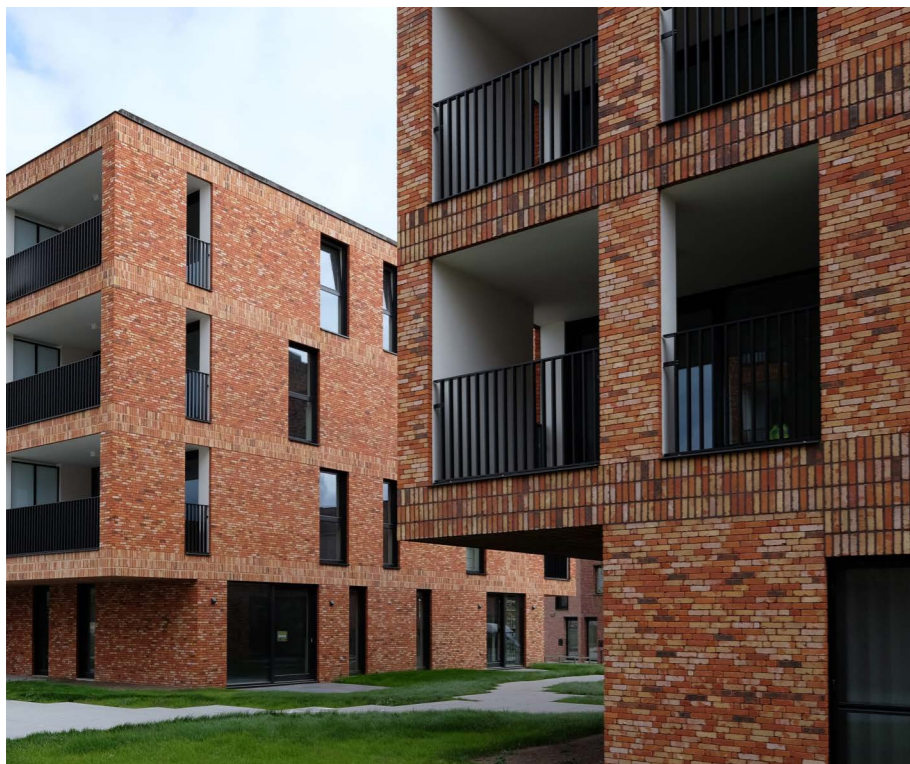
Appartementen Pier Kornel (BE-Aalst)
